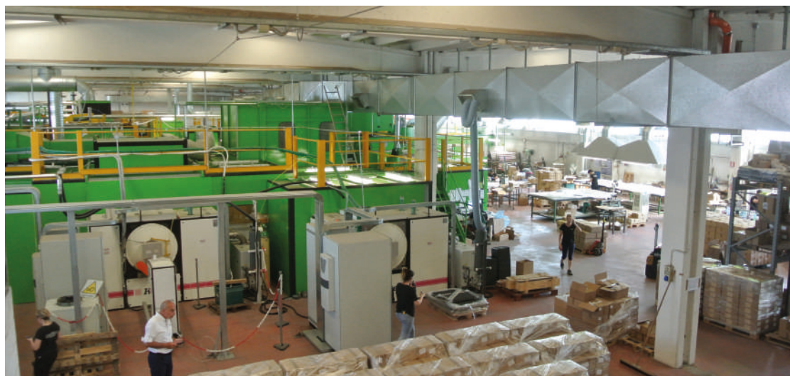
1 – Una vista generale di uno degli impianti di verniciatura e PVD sputtering installati alla Cosmotec di Gropello Cairoli, in provincia di Pavia (Italia).
